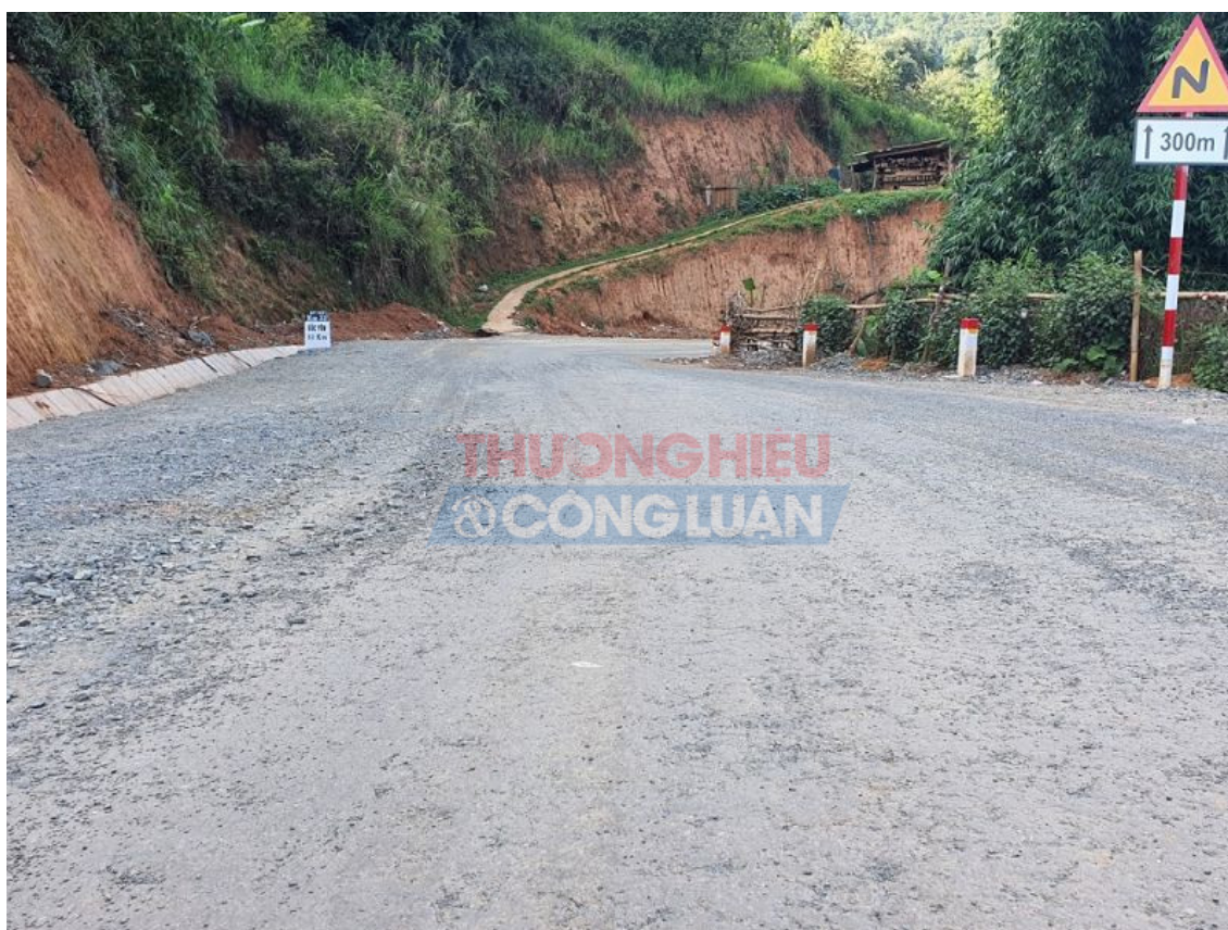
Một đoạn thuộc dự án thi công cải tạo, nâng cấp đường tỉnh 112 (đoạn Làng Chếu - Xím Vàng)
