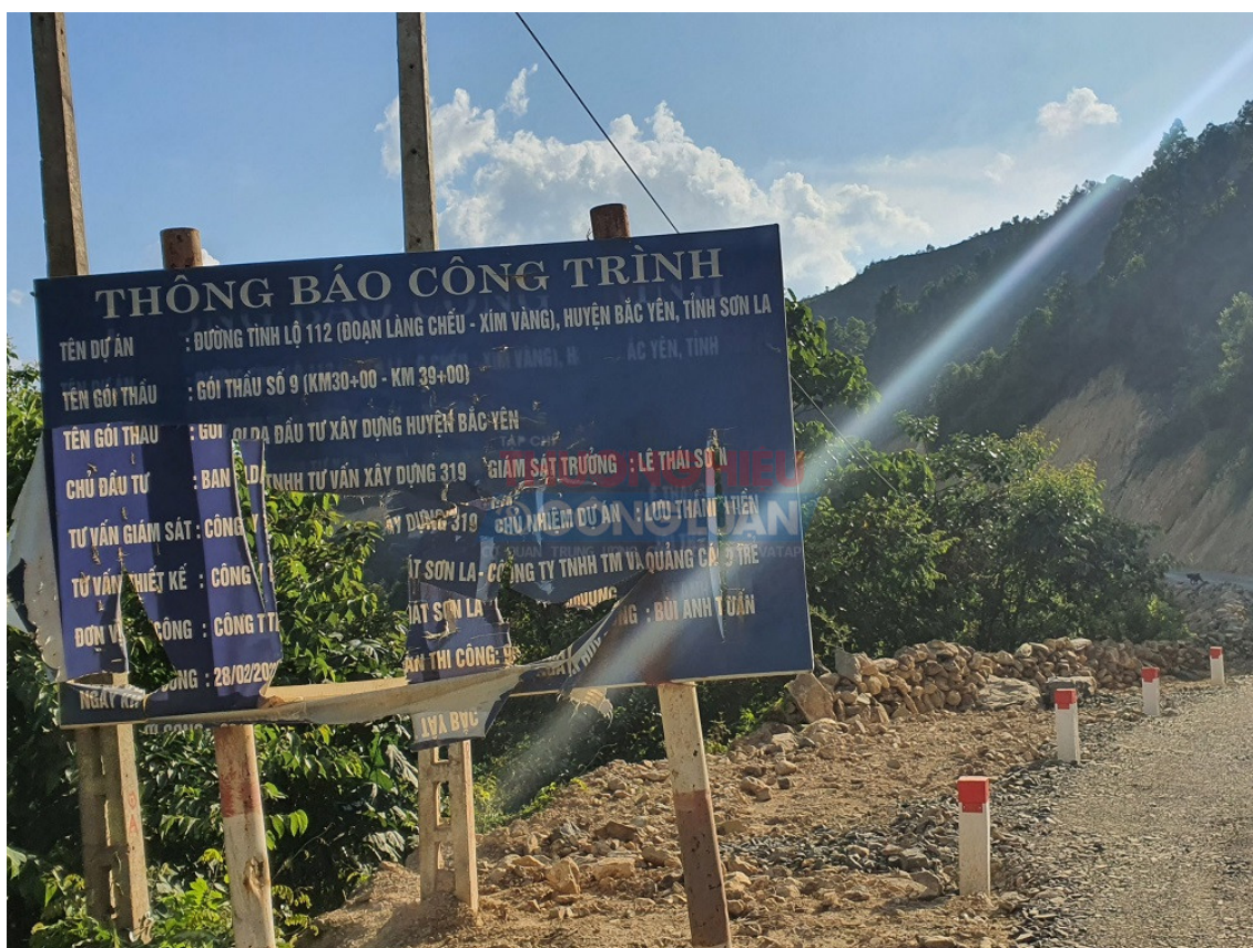
Biển báo công trình tại Gói thầu số 09: Thi công xây dựng đoạn Km30-Km39 dự án đường tỉnh 112 (đoạn Làng Chếu - Xím Vàng) do Công ty Tân Phát Sơn La trúng thầu.
