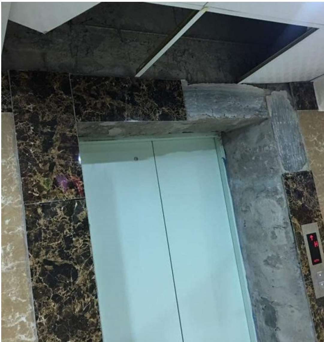
Hiện trạng khu thang máy tầng 21, tòa T2
