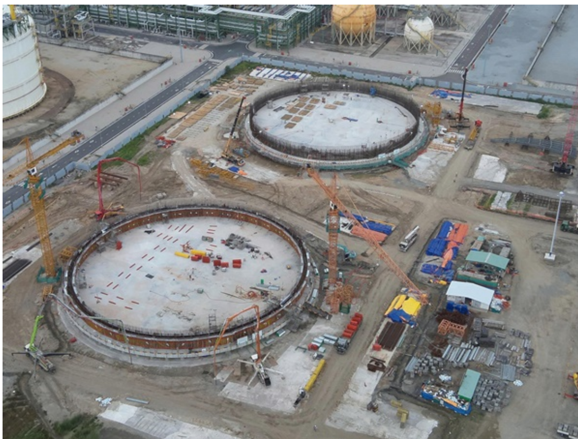
Dự án Cải tạo LSP: Xây dựng 2 bể chứa ethane siêu lạnh
