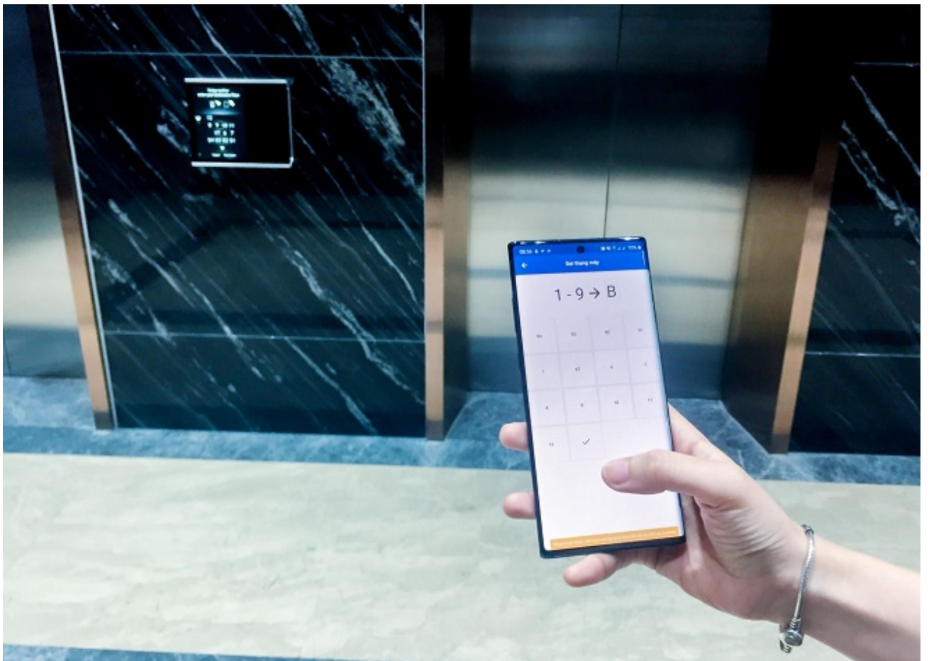
Hệ thống gọi thang máy tự động bằng điện thoại giúp hạn chế tối đa việc tiếp
