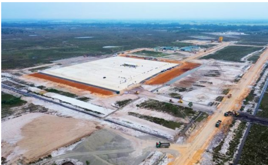
Liên doanh T&T Group – Cienco 4 đẩy nhanh thi công các hạng mục dự án Cảng hàng không Quảng Trị.
