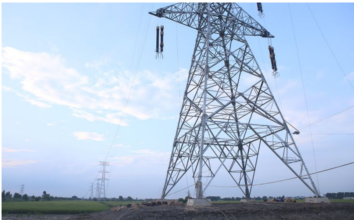
Những khoảng néo đầu tiên của Dự án đường dây 500kV NMNĐ Nam Định I – Phố Nối đang được tổ chức kéo dây
