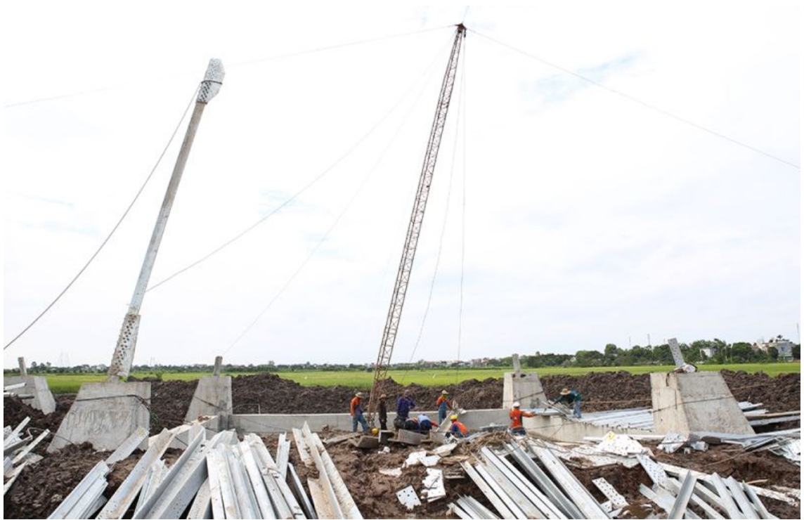
Nhà thầu Sông Đà 11 thi công dựng cột Dự án đường dây 500kV NMNĐ Nam Định I – Phố Nối
