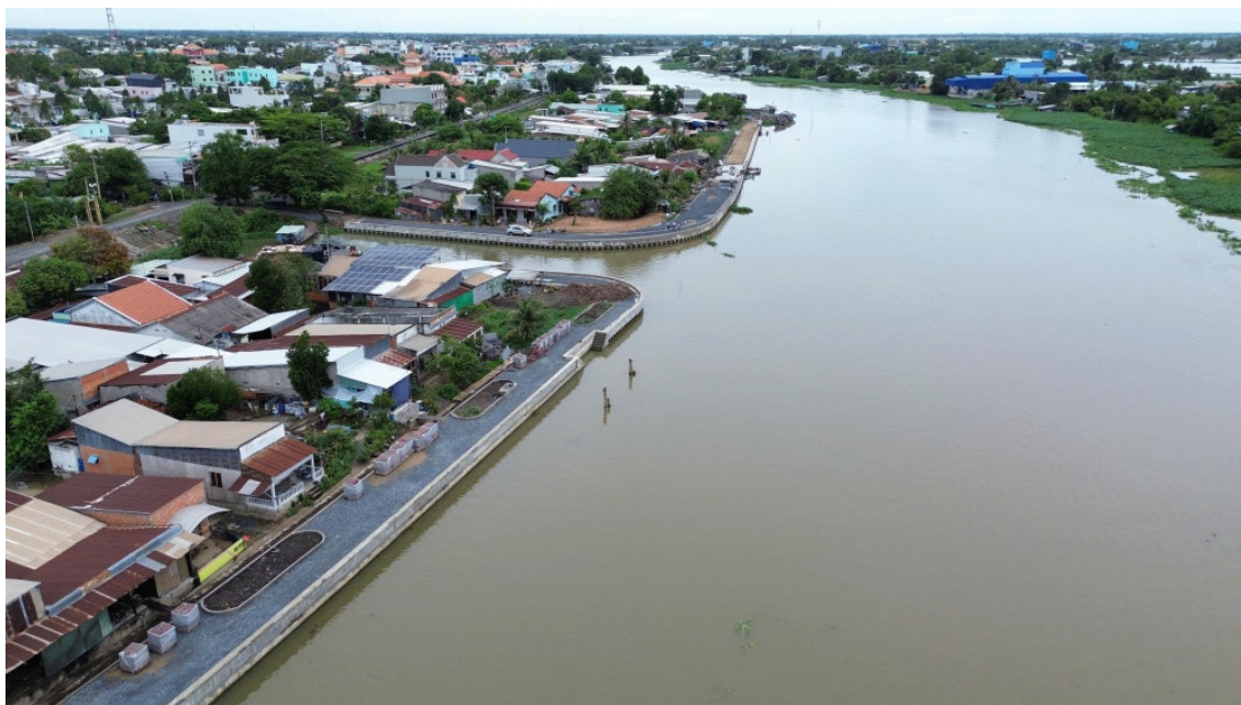
Công trình kè đang tiến hành thi công
