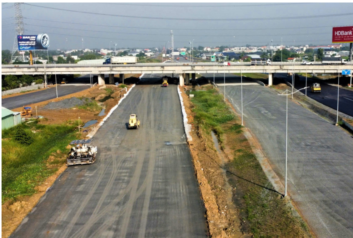
Tỉnh Tây Ninh tập trung đẩy nhanh tiến độ hàng loạt dự án giao thông trọng điểm để góp phần giải ngân vốn đầu tư công. (Ảnh: KT)
