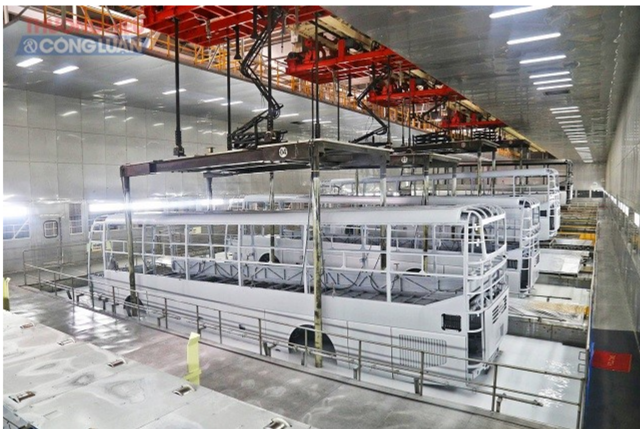
Dây chuyền sơn tĩnh điện tại nhà máy bus Thaco
