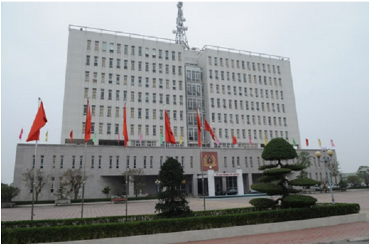
Trụ sở Công an tỉnh Thái Bình
