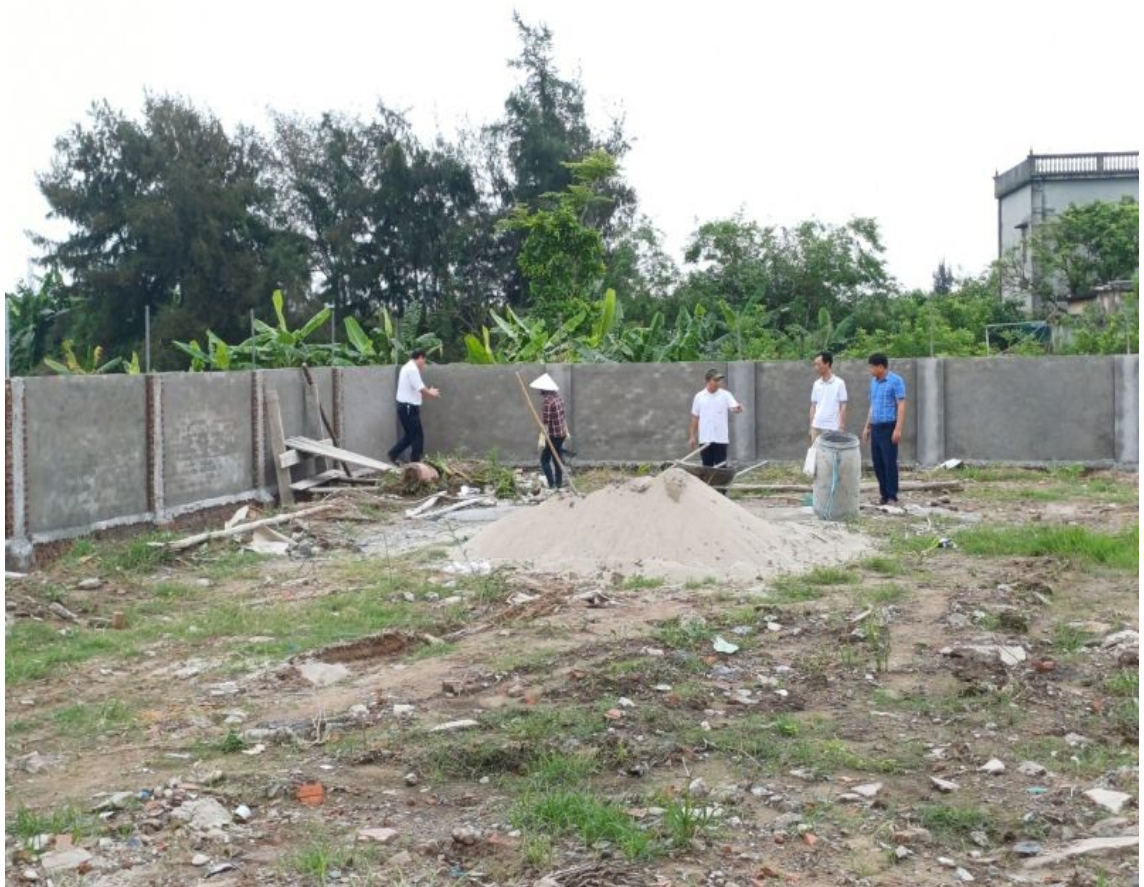
Sân nhà văn hoá thôn Hợp Châu xã Nam Thịnh đang được xây dựng
