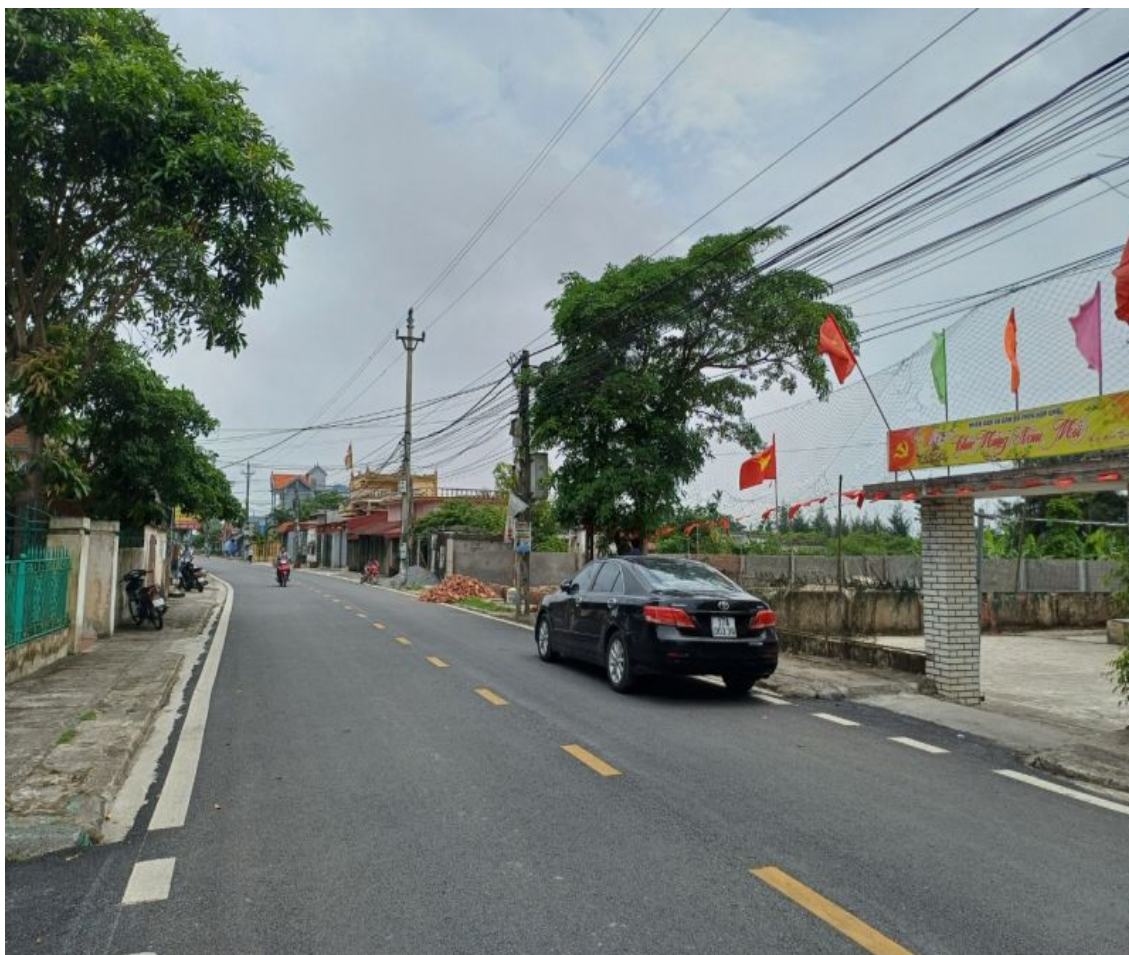
Con đường trục xã qua Nhà văn hoá thôn Hợp Châu xã Nam Thịnh
