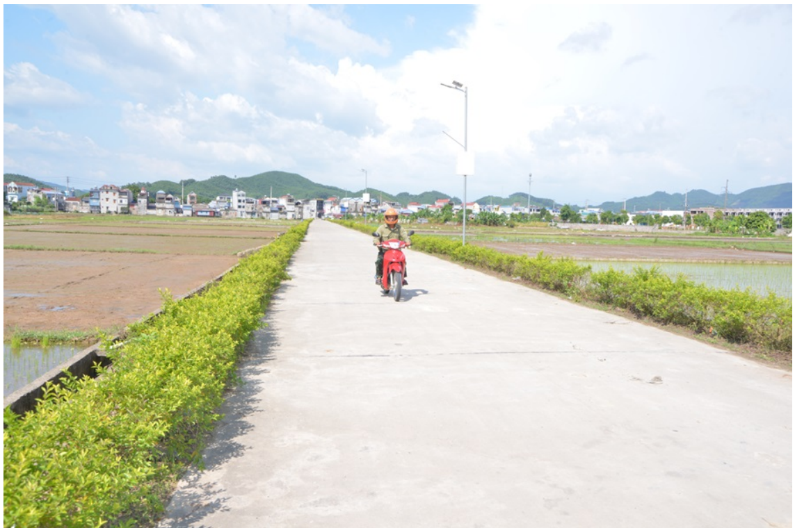
Tuyến đường mẫu xóm Bải Cải, xã Đại Từ được thực hiện theo Chương trình mục tiêu quốc gia xây dựng nông thôn mới
