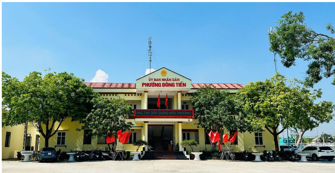
Trụ sở UBND phường Đông Tiến, tỉnh Thanh Hóa
