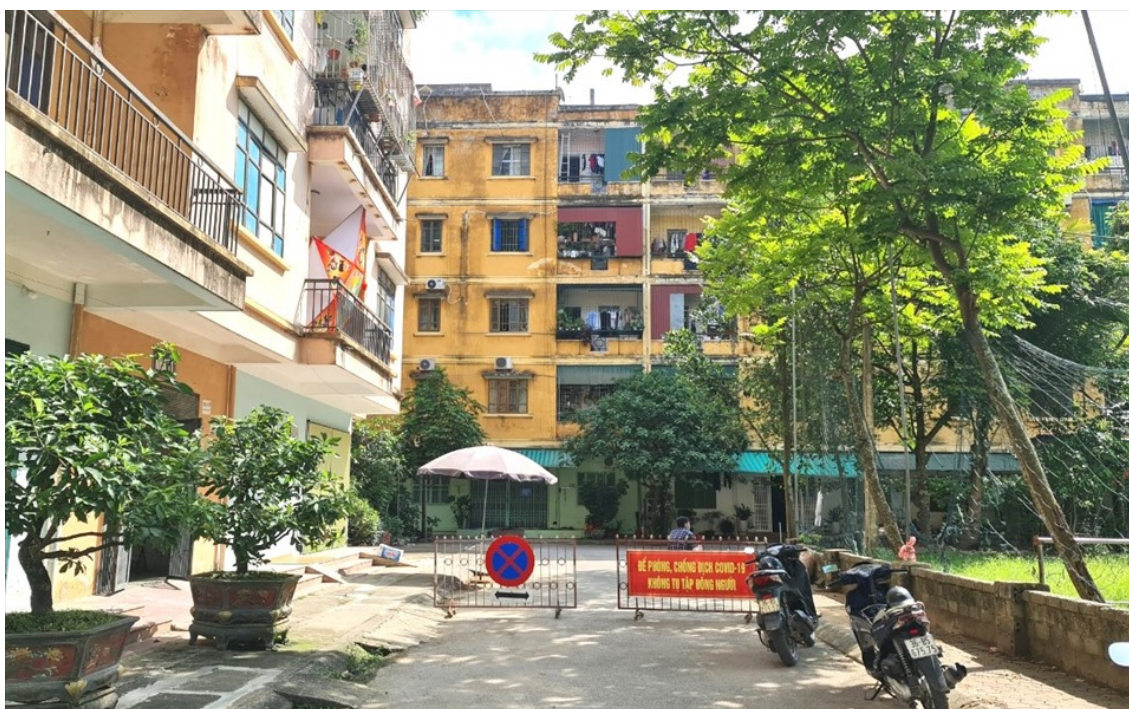
Chung cư Đông Phát (phường Hạc Thành) nằm trong danh sách 42 cơ sở không bảo đảm PCCC
