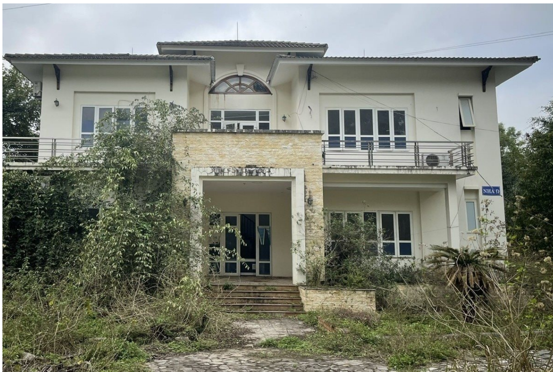
Hạng mục nhà sinh thái bỏ hoang để cỏ mọc
