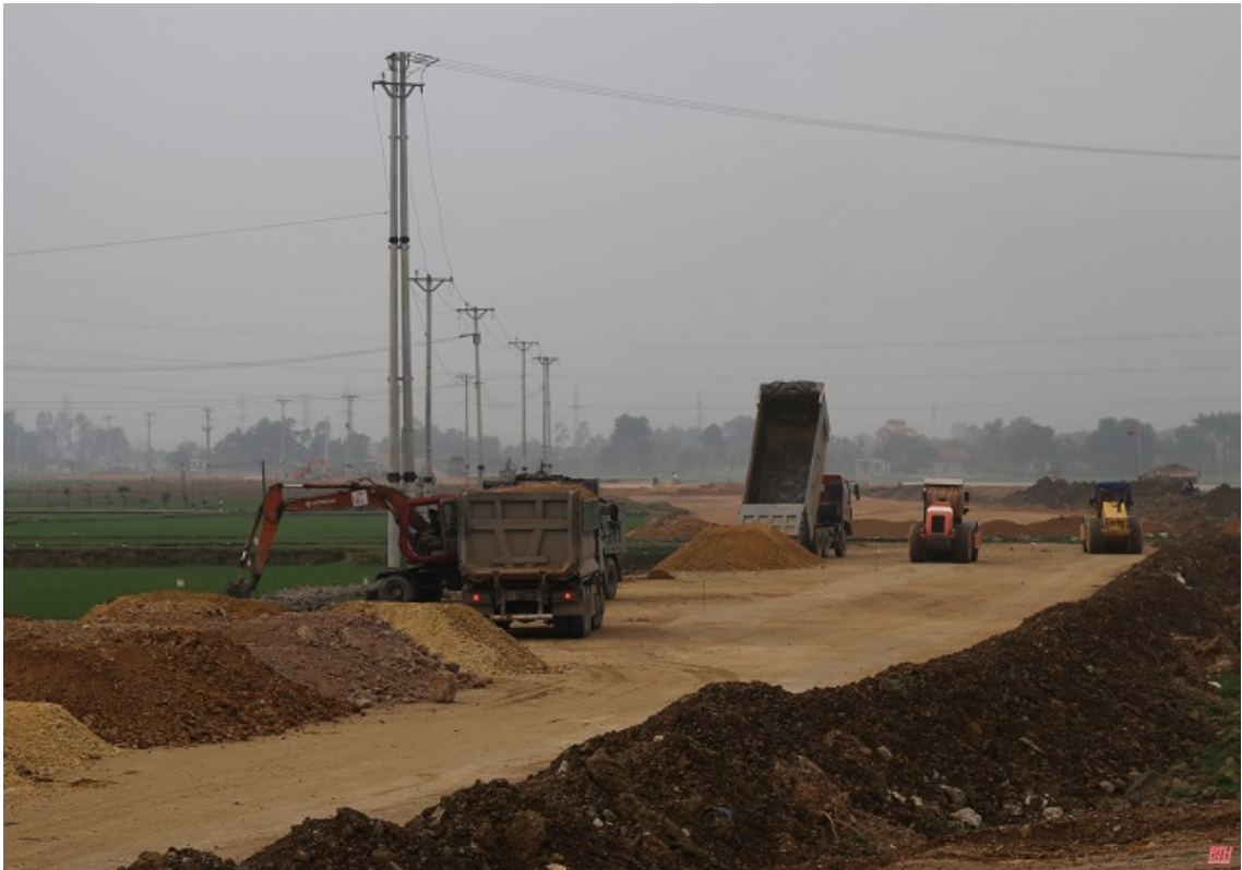
Công trường thi công dự án.
