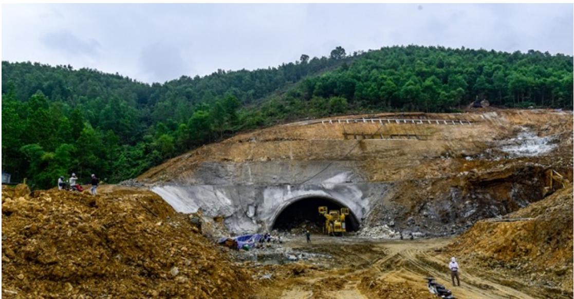
Công trường thi công hầm Thung Thi đoạn qua huyện Hà Trung, tỉnh Thanh Hóa
