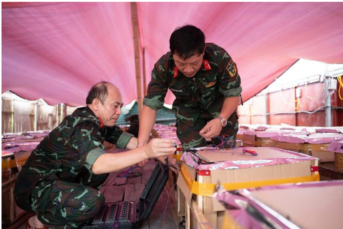
Cán bộ, chiến sĩ kiểm tra, đấu nối hệ thống điều khiển điện tử cho giàn pháo hoa.
