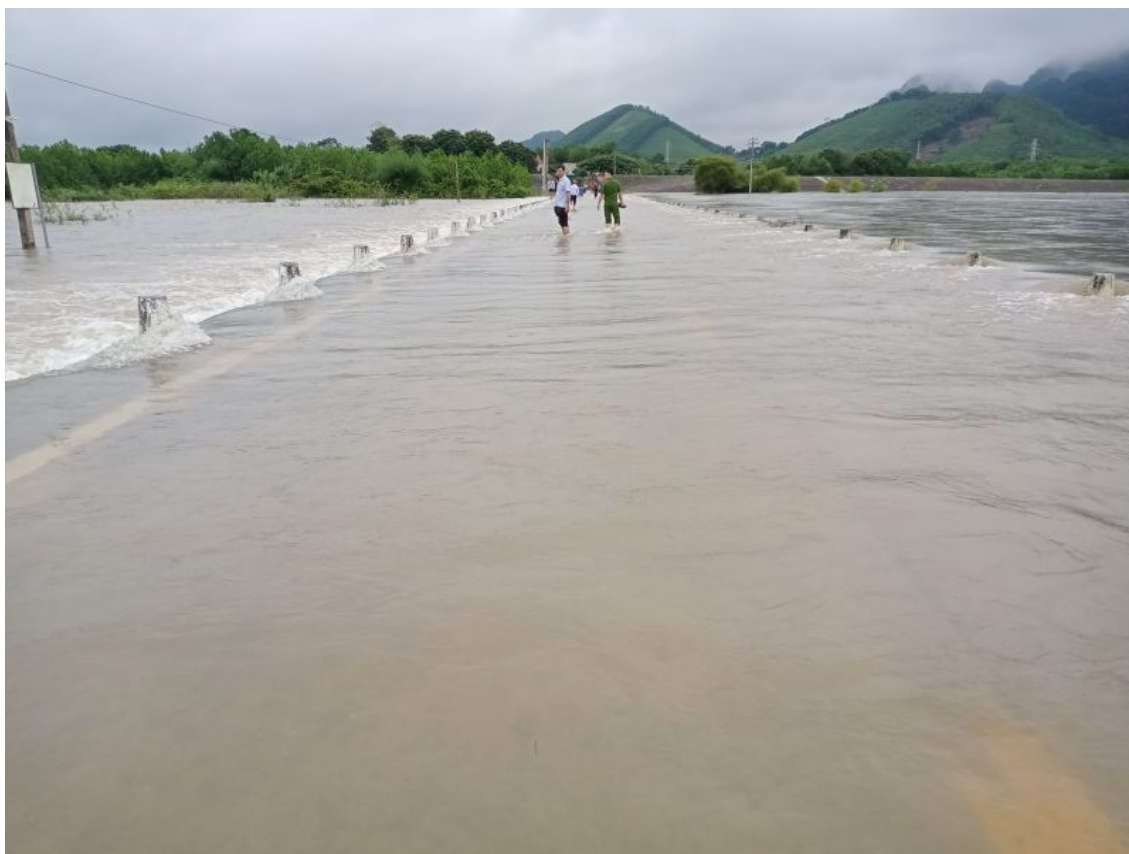
Nước ngập khu vực cầu Trần, huyện Như Thanh, tỉnh Thanh Hoá.
