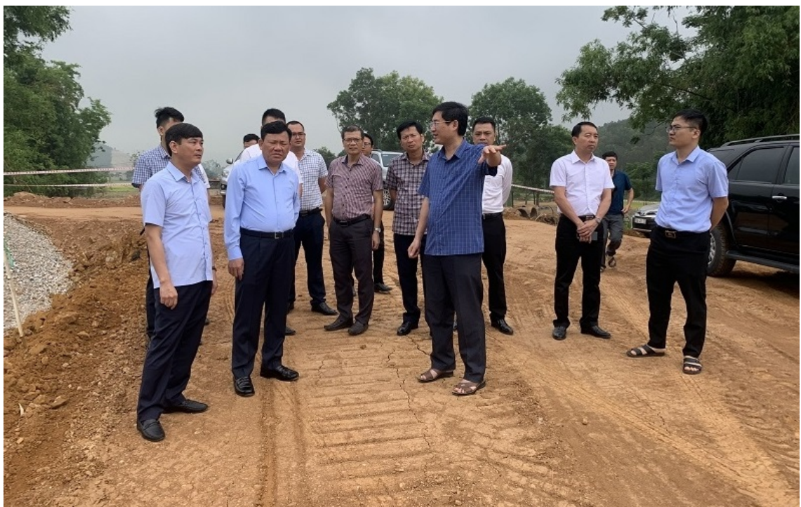
Tổ công tác kiểm tra tiến độ thi công Dự án Đường giao thông kết nối khu đô thị Hà Lĩnh (Hà Trung)
