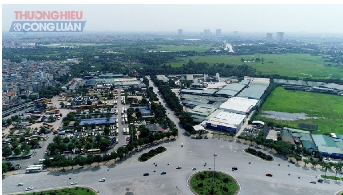
Hàng loạt nhà xưởng, hàng quán, gara ô tô, trạm trộn bê tông tại Khu LHTT quốc gia Mỹ Đình
