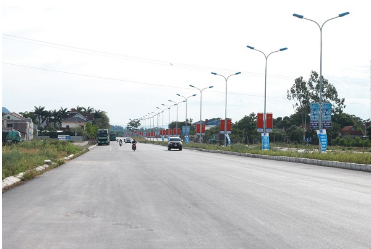
Tuyến đường 2 đầu cầu Hiếu được xây dựng hoàn thiện
