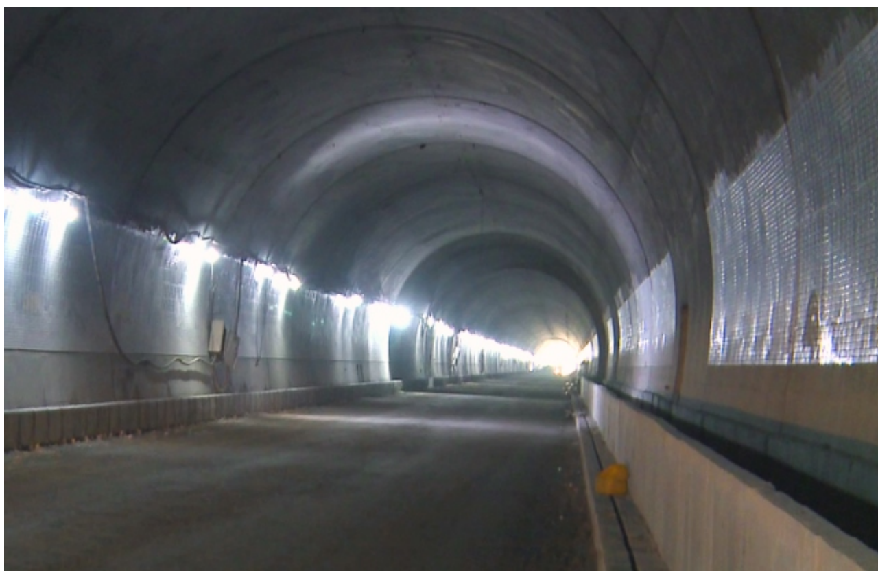
Hầm Hải Vân 2 trong giai đoạn hoàn thiện
