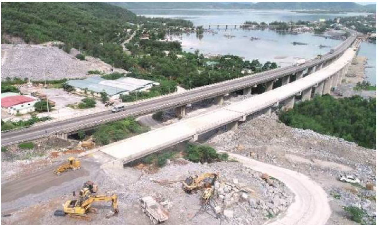
Cầu Bắc Hải Vân bắc qua đầm Lập An (thị trấn Lăng Cô) dẫn vào hầm Hải Vân 2 đang gấp rút thi công. Theo thiết kế, cầu dài gần 2 km với hai làn xe.
