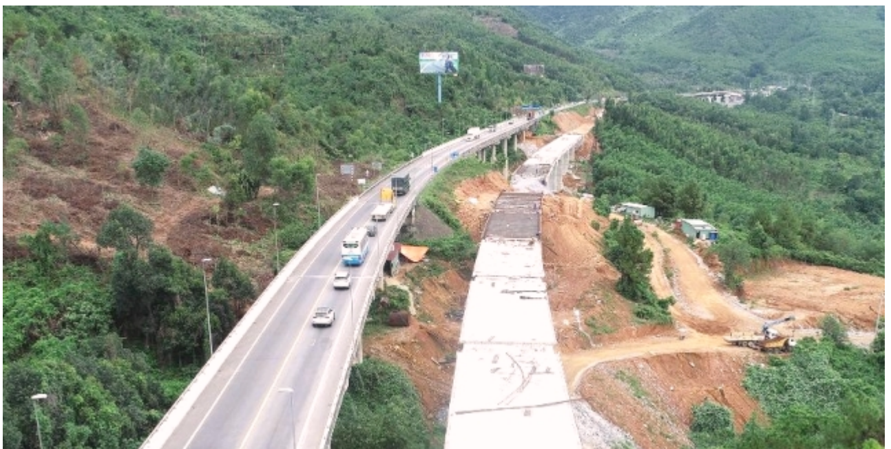
Đường dẫn vào hầm Hải Vân 2 ở phía TP. Đà Nẵng dài 4km gồm 5 cầu bắc qua suối, khe núi
