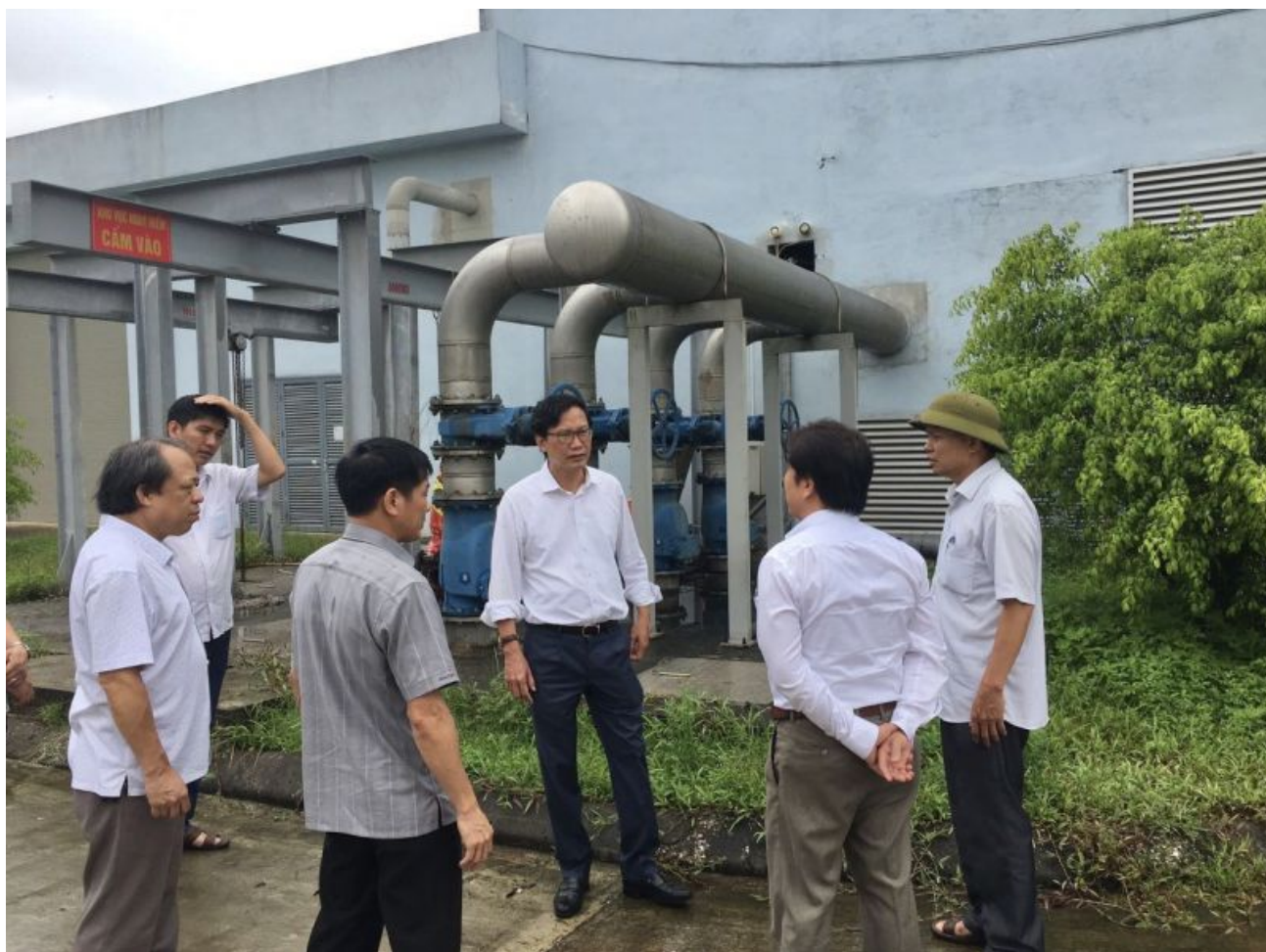
Thứ trưởng Bộ Xây dựng đi kiểm tra nhà máy nước thải Gia Sàng T.P Thái Nguyên
