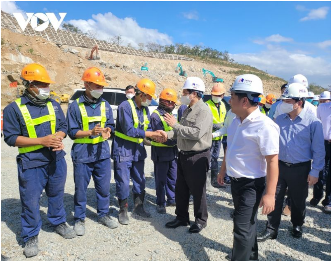
Thủ tướng Chính Phủ Phạm Minh Chính kiểm tra công trường thi công cao tốc Bắc-Nam ngày mừng 2 Tết tại đoạn tuyến Cam Lâm-Vĩnh Hảo..
