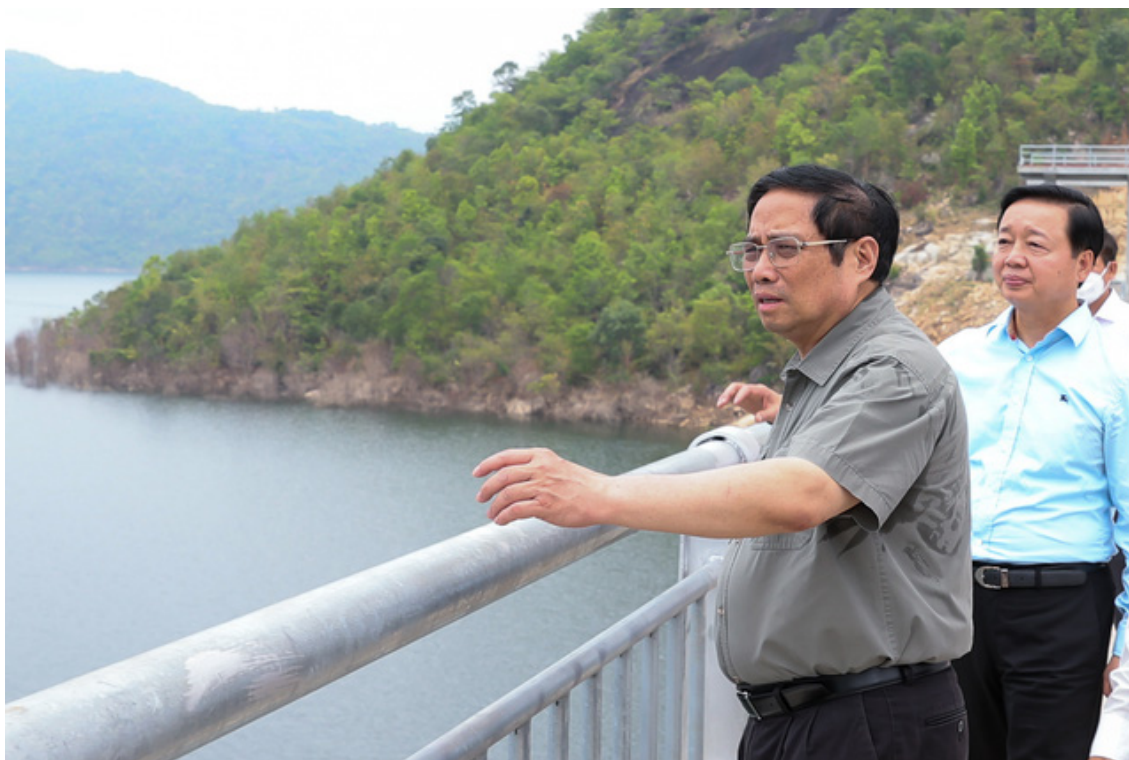
Thủ tướng Phạm Minh Chính thăm, kiểm tra công trình hồ chứa nước Sông Cái. Ảnh: VGP/Nhật Bắc.
