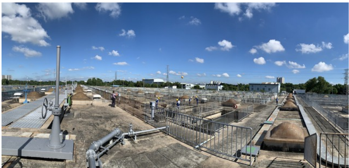
Quang cảnh Nhà máy xử lý nước thải Bình Hưng. Ảnh VGP/Nhật Bắc.
