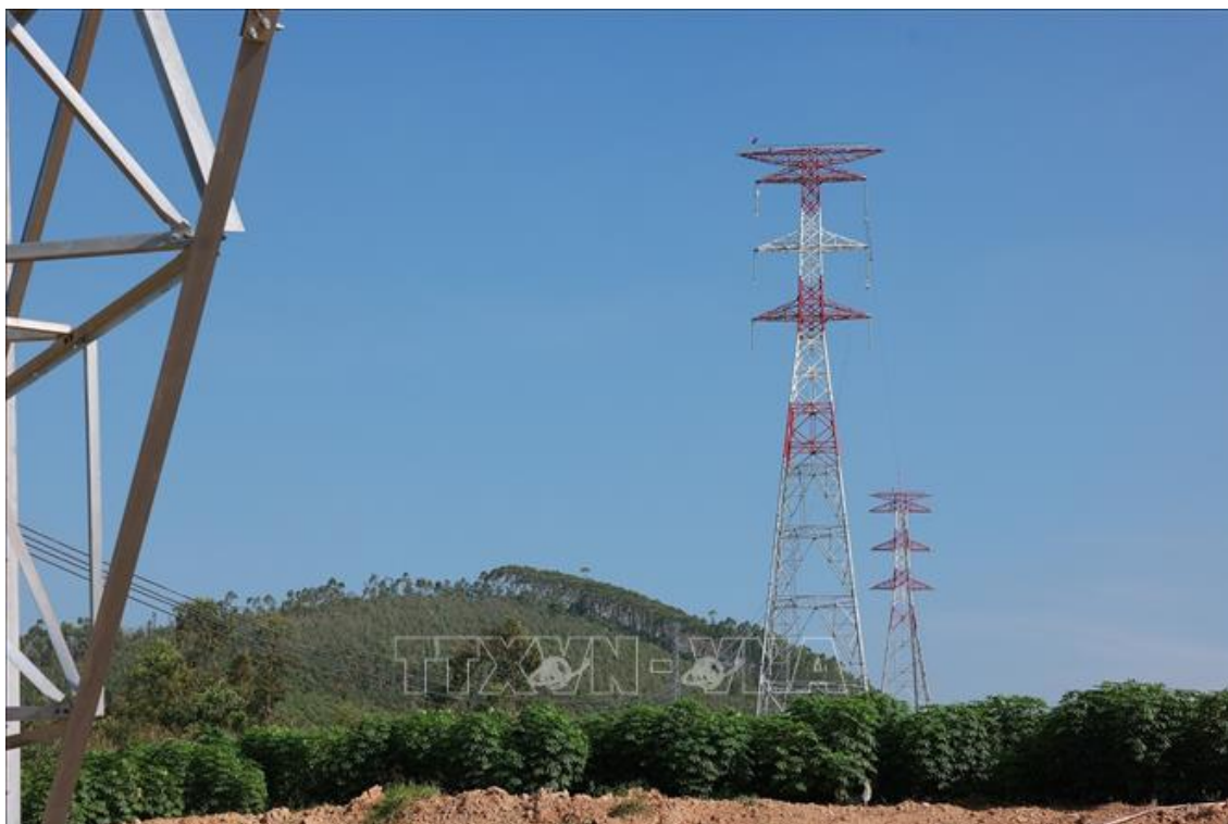
Dự án Đường dây 500kV Lào Cai - Vĩnh Yên đang thi công trên địa bàn xã Thái Hoà, tỉnh Phú Thọ. Ảnh: Dương Giang/TTXVN
