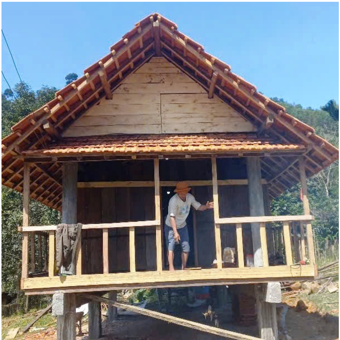
Nhà ở của Chương trình xóa nhà tạm, nhà dột nát của người dân Sơn Tây, tỉnh Quảng Trị hoàn thành bàn giao, đưa vào sử dụng. Ảnh VGP.
