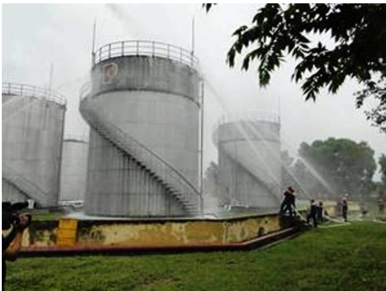
Kho cảng xăng dầu, gas tại Thuận An, Phú Vang từng được tập đoàn Petrolimex đầu tư qui mô nhưng đã được bán phế liệu năm 2018
