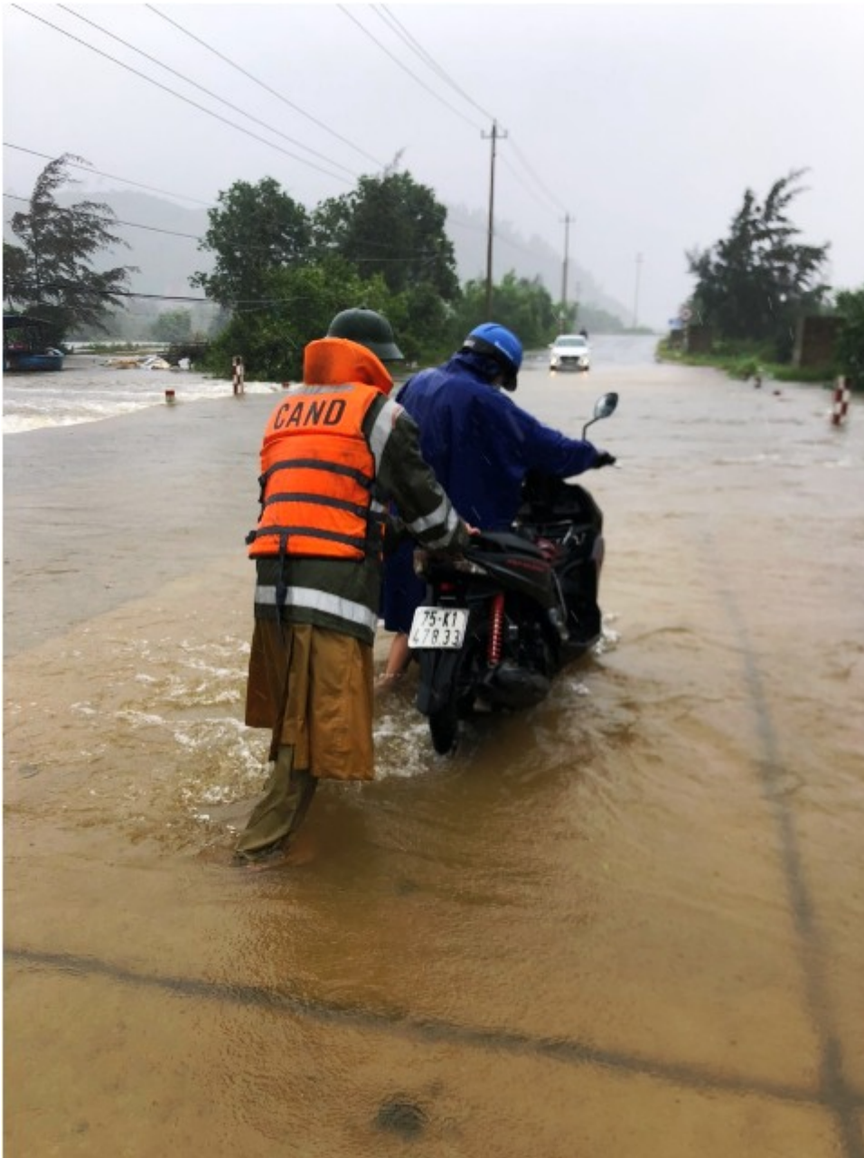
Đoạn đường qua xã Lộc Vĩnh (Phú Lộc) nước tràn qua đường.
