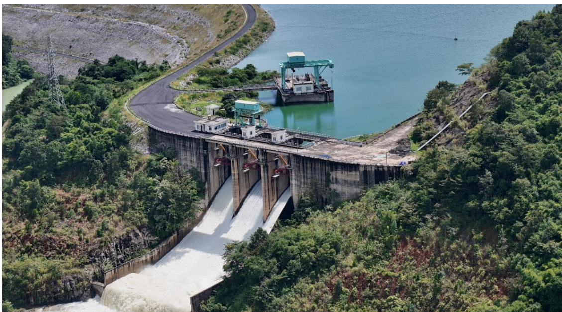
Đập thủy điện Nhà máy Thủy điện Buôn Tua Srah
