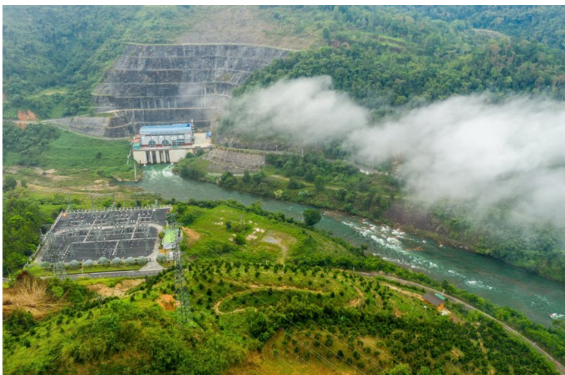
Nhà máy và Trạm phân phối 220 kV Thủy điện Đồng Nai 3
