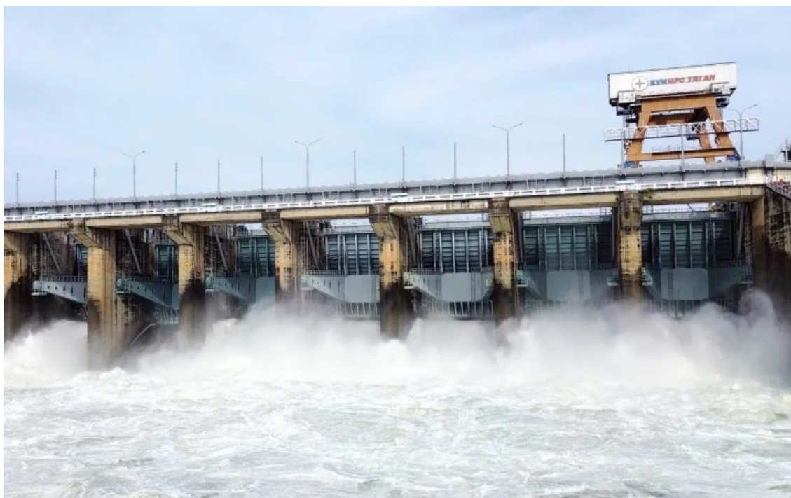
Thủy điện Trị An tăng lượng nước xả xuống hạ du. Ảnh: Hoàng Lộc
