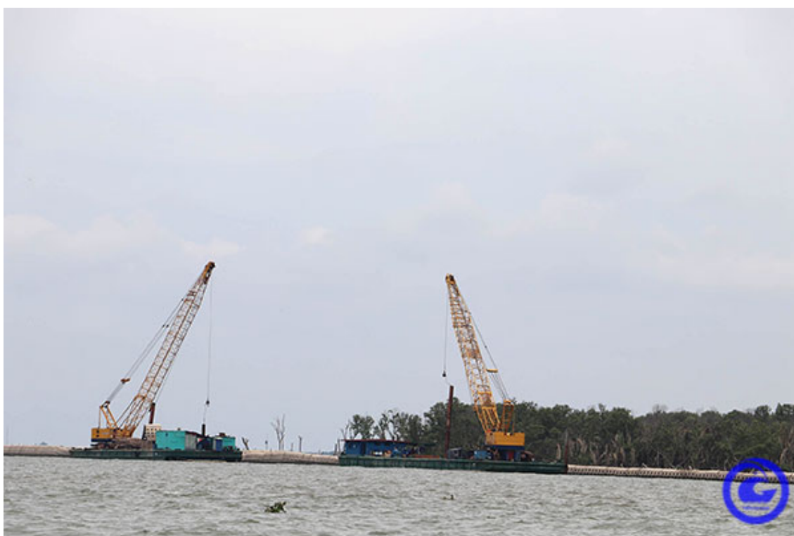
Thi công kè cồn Ngang, huyện Tân Phú Đông (Ảnh: KT)
