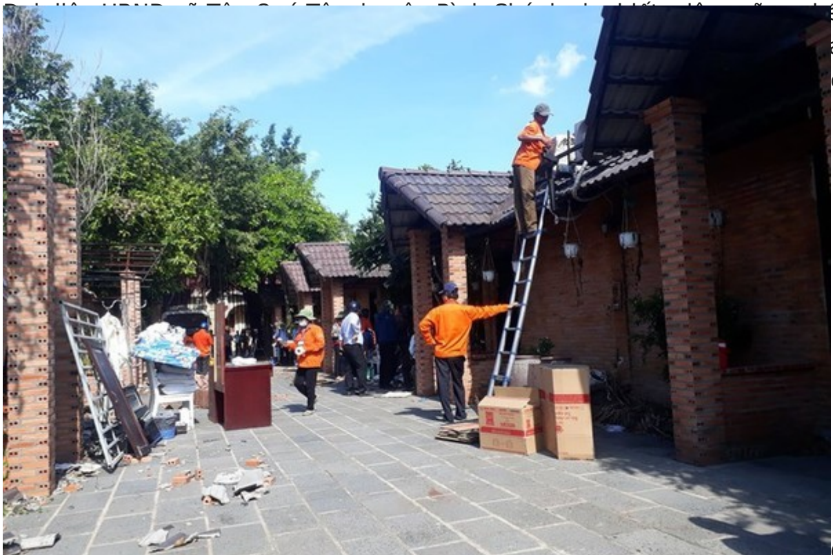
Ảnh: Công nhân đang thi công tại Gia Trang quán - Tràm Chim Resort.
