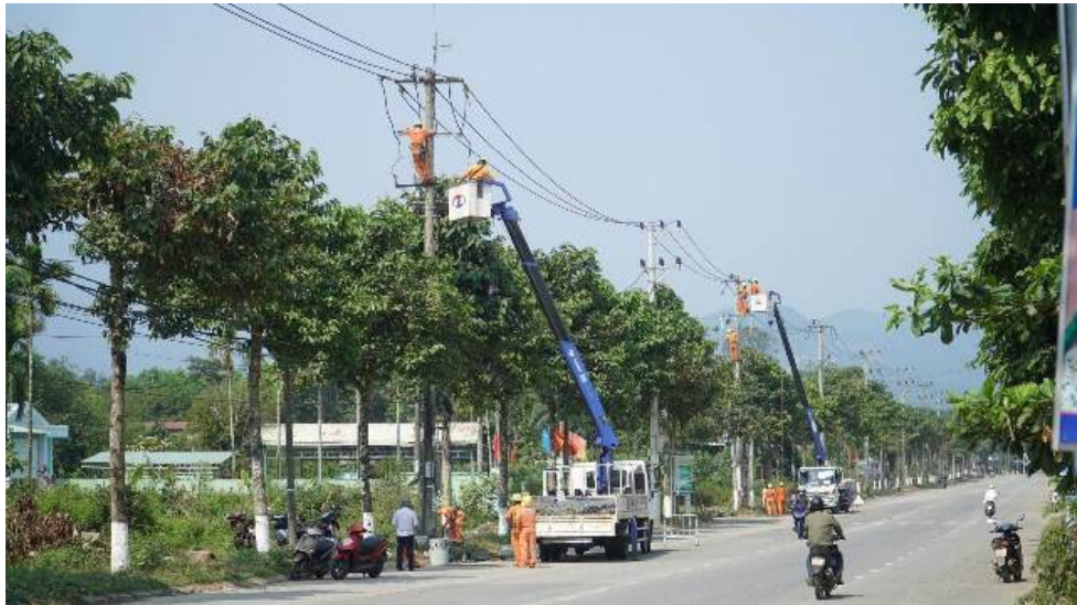
Công nhân thi công bảo dưỡng đường dây
