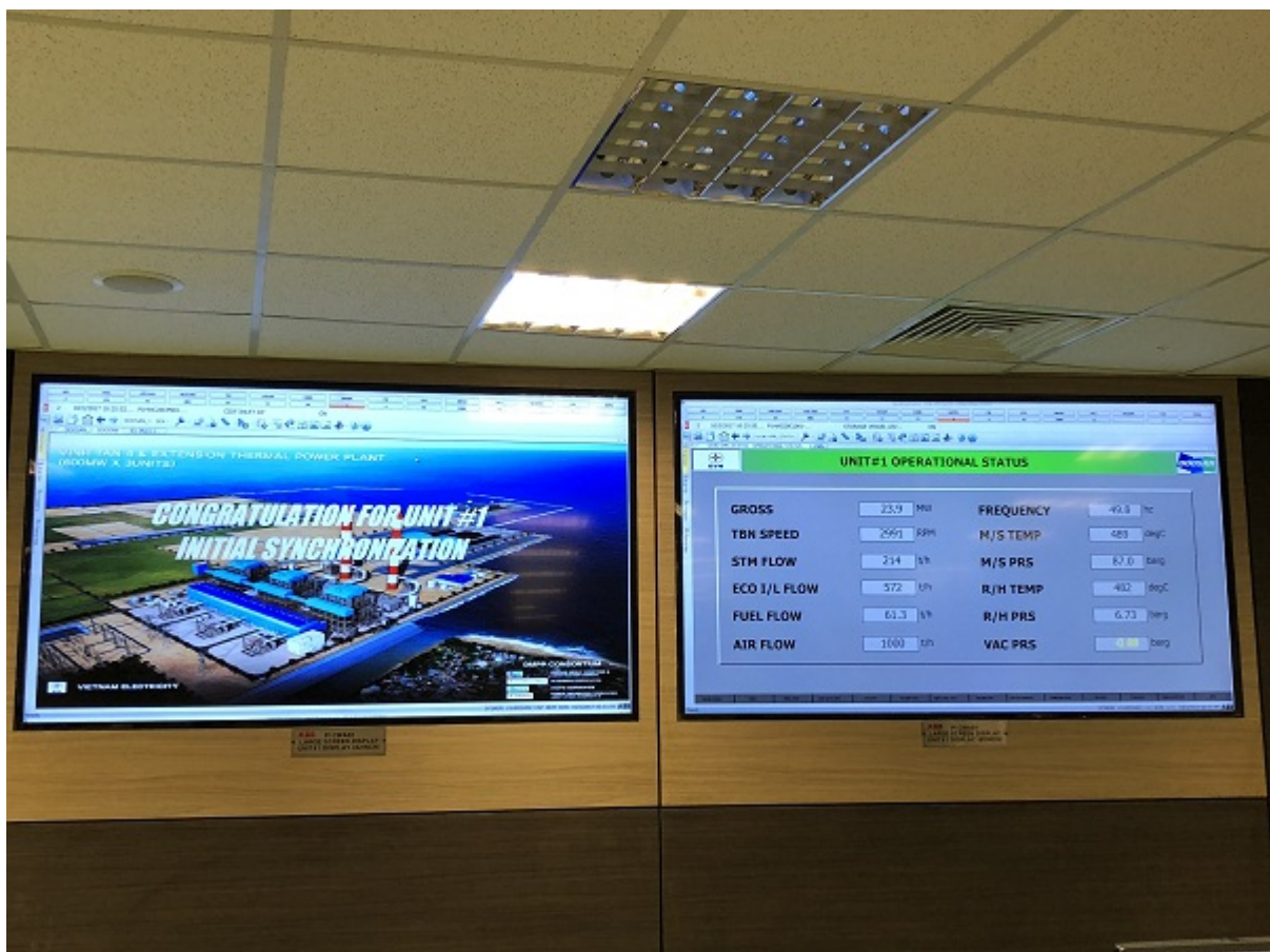
Bảng thông số vận hành Tổ máy số 1 NMNĐ Vĩnh Tân 4 khi hòa lưới
