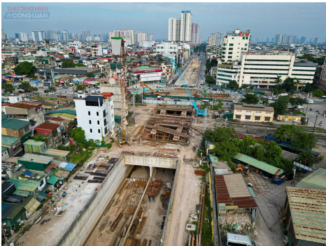
Dự án hầm chui Kim Đồng - Giải Phóng khởi công tháng 10/2022, tổng mức đầu tư 778 tỷ đồng, do Ban Quản lý dự án đầu tư xây dựng công trình giao thông Hà Nội làm chủ đầu tư.
