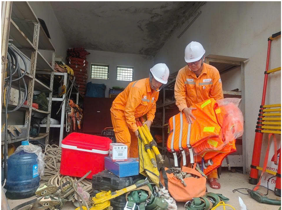
PC Sơn La chuẩn bị phương tiện vật tư lên đường hỗ trợ khắc phục hệ thống lưới điện tại tỉnh Nghệ An
