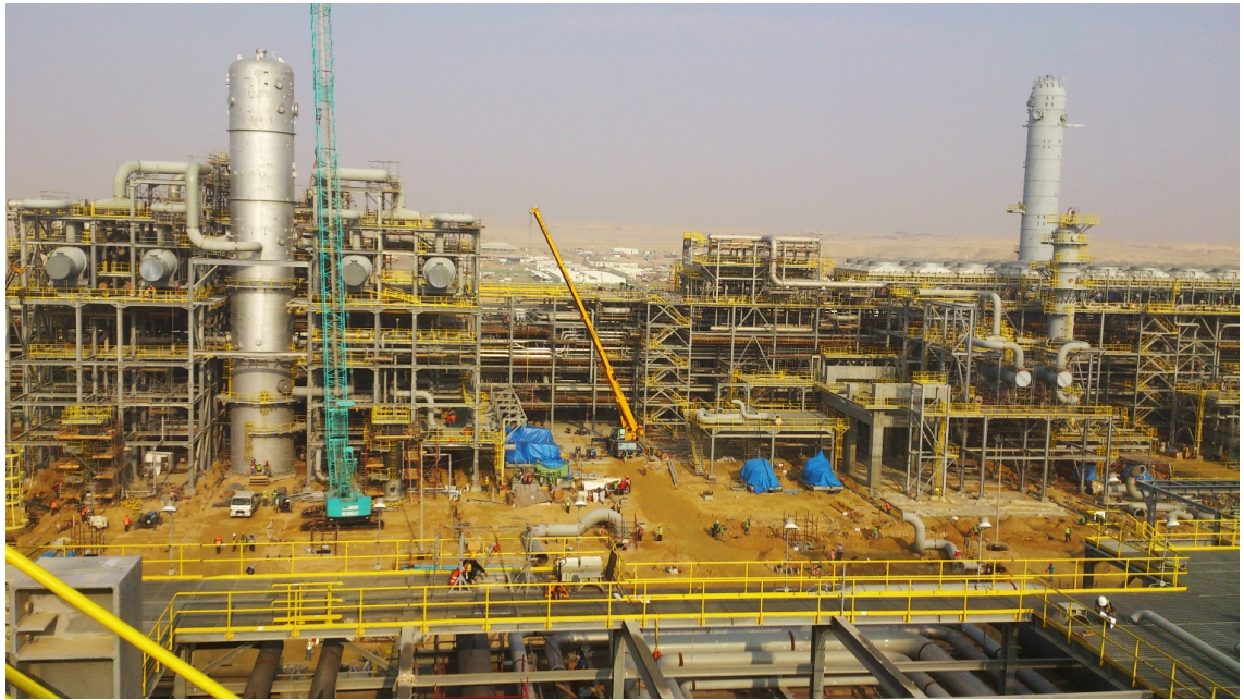
Nhà máy Lọc hóa dầu Nghi Sơn
