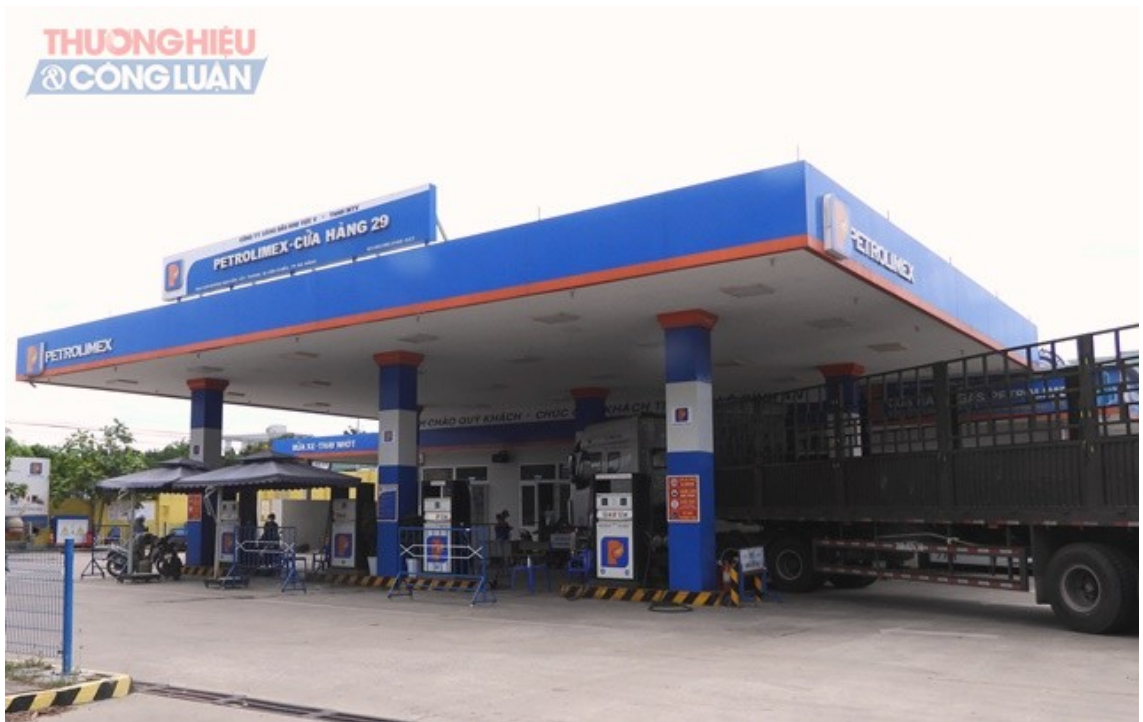
Cây xăng ngã tư đường Nguyễn Tất Thành và đường Nguyễn Lương Bằng
