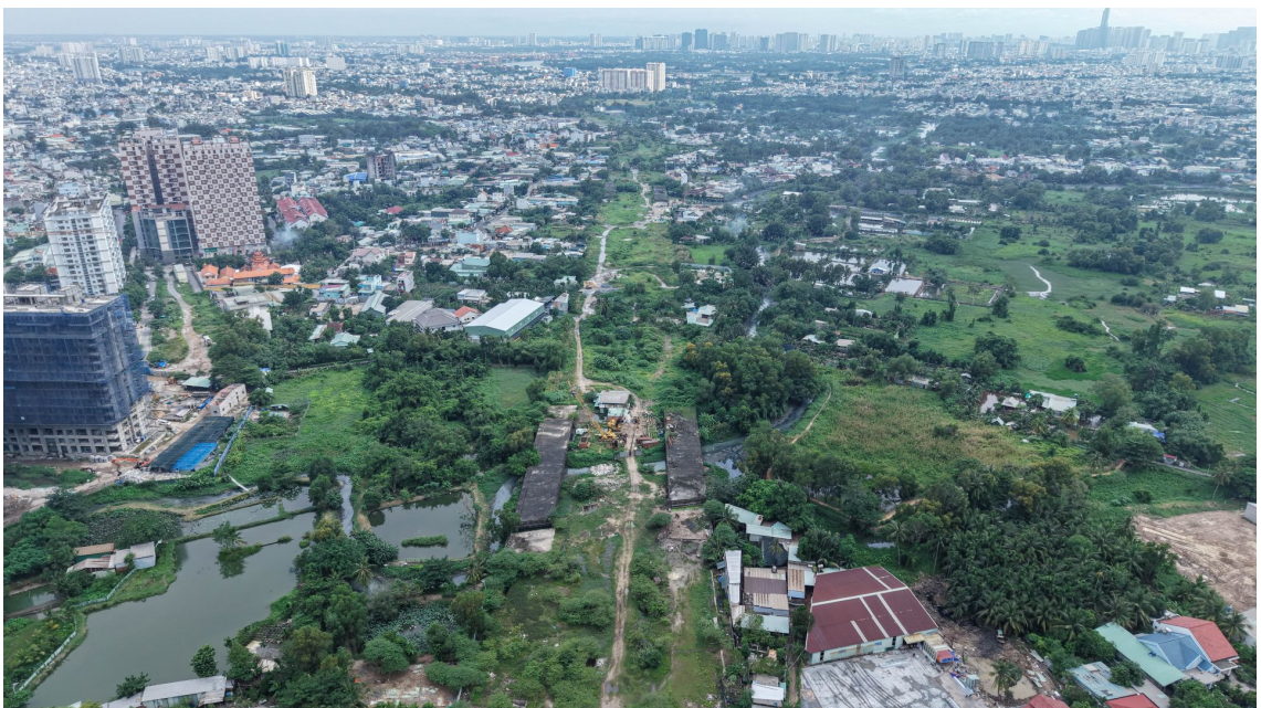
Một phần dự án đường Vành đai 2 (Ảnh: Thuận Văn)
