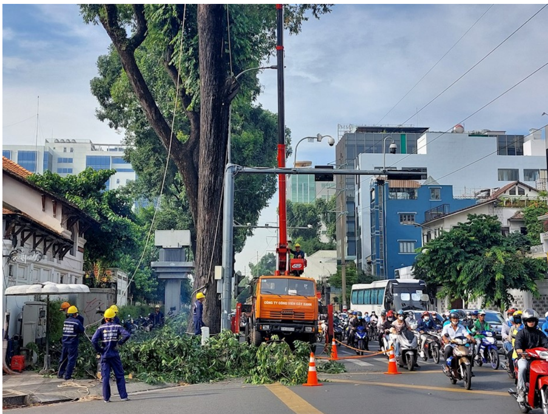
Cắt tỉa cây xanh trên đường phố ở TP. HCM để tránh xảy ra những sự cố trong mùa mưa bão (Ảnh: Thanhuytphcm.vn)
