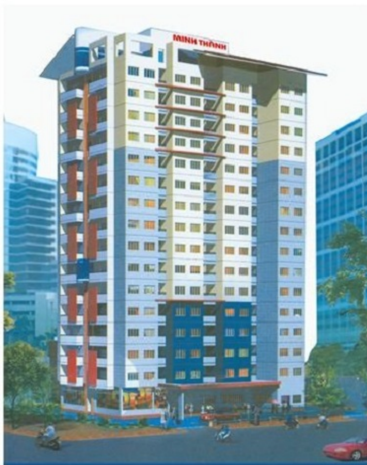
Chung cư Minh Thành xây vượt 1 tầng
