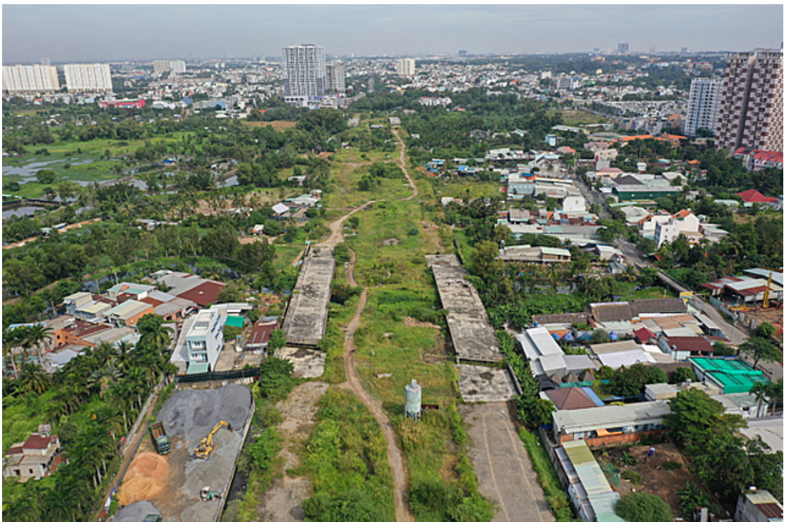
Công trường đoạn Vành đai 2 từ đường Phạm Văn Đồng đến nút giao Gò Dưa cuối năm 2021, sau khi dừng thi công. Ảnh: Quỳnh Trần.
