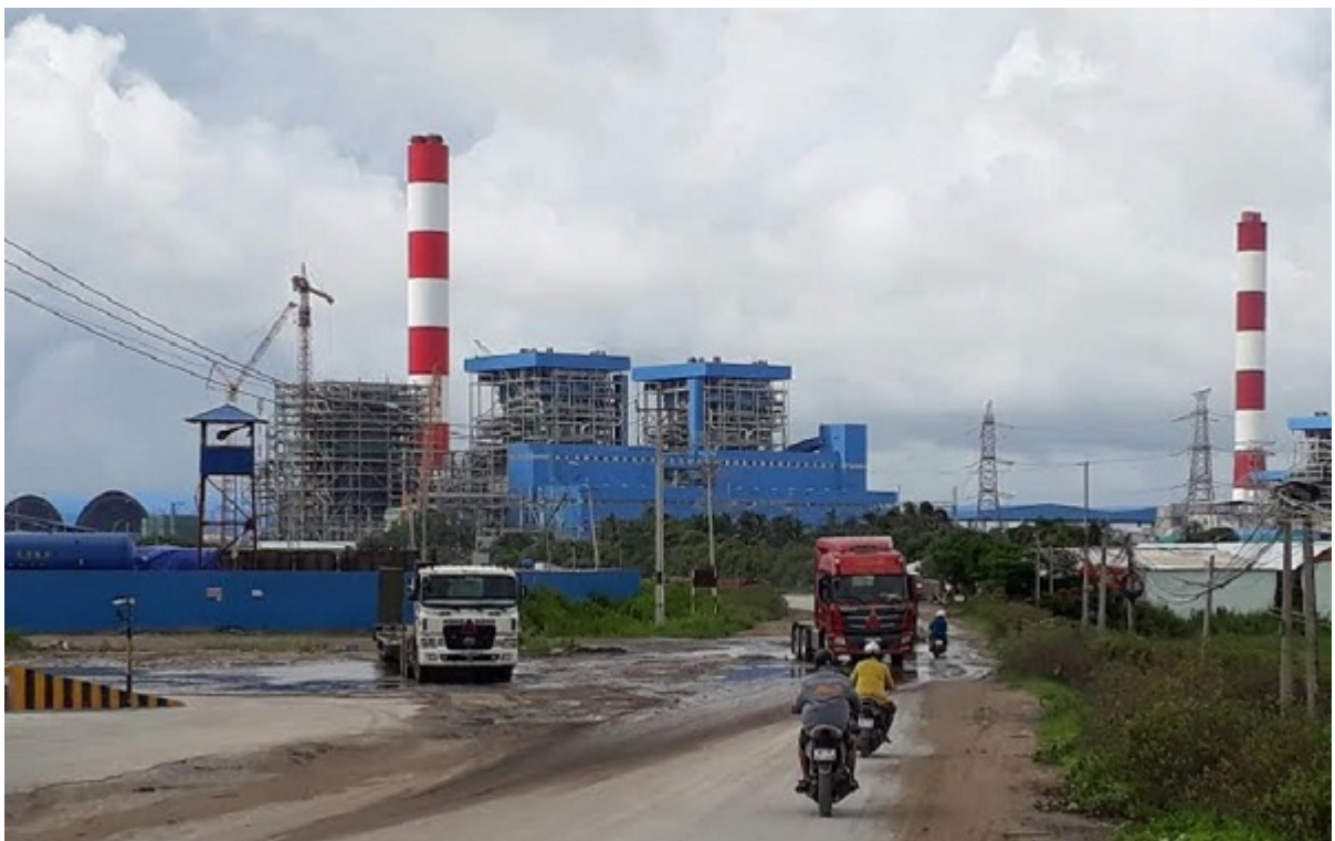
Vận chuyển tro xỉ từ nhà máy nhiệt điện Duyên Hải
