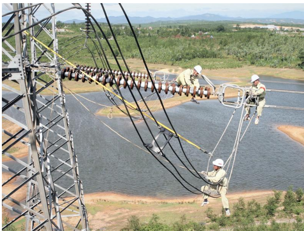
Thi công đường dây 500 kV mạch 3. Ảnh: H.M
