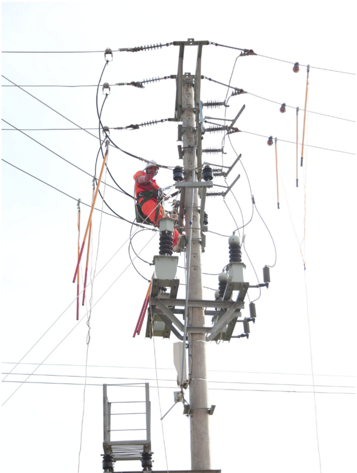
Công nhân Điện lực khắc phục sự cố lưới điện trong nắng nóng.
